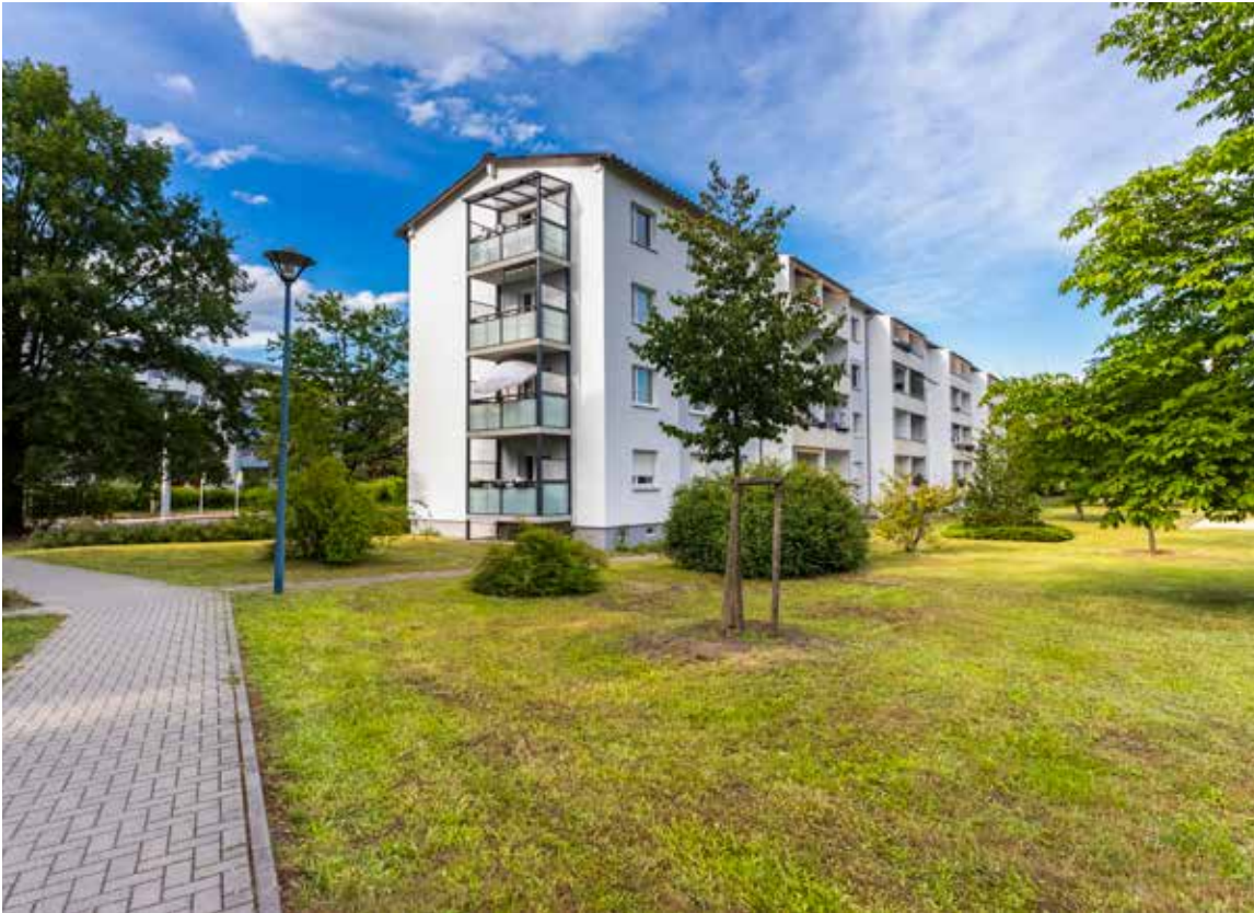
Anbau von Giebelbalkonen, Vetschauer Straße 30-34
