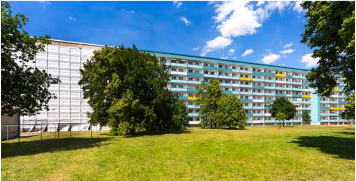
Balkon- und Fassaden- instandsetzung, Albert- Förster-Straße 4-6
