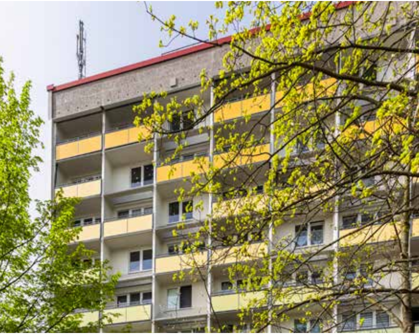
Balkon- und Fassadeninstandsetzung, Saarstraße 44
